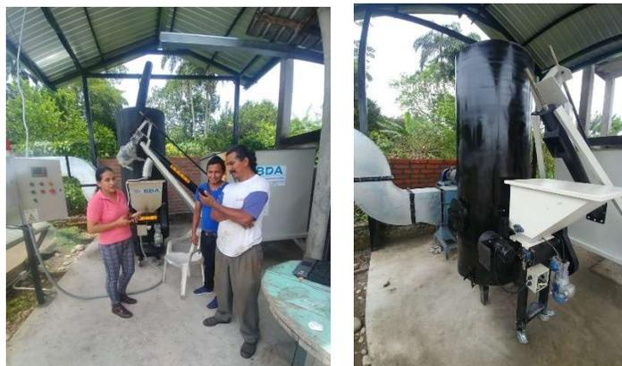
**Figura 9.** Sistema de combustión de lecho móvil y propagación de llama horizontal instalado en APROCEL.
