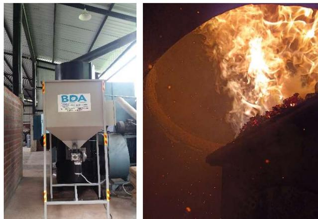
**Figura 8.** Sistema de combustión de lecho fijo y propagación de llama vertical instalado en APROCEL.
